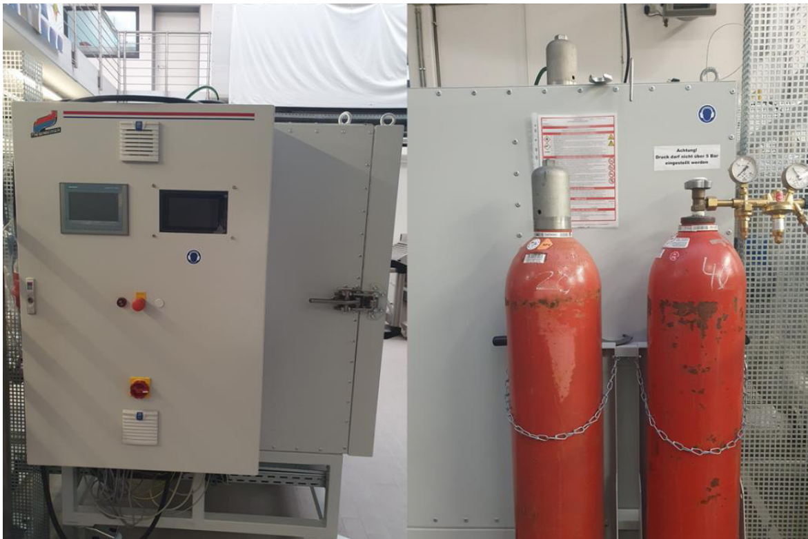
Abbildung 9: Seitenansichten des Wasserstoffbackofens. (links: Schaltschrank zur Steuerung der Anlage; rechts: Vorrichtung zum Fixieren der Wasserstoffdruckgasflaschen).
