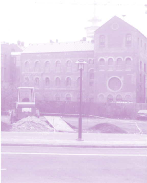
Im ersten Bauabschnitt (1982–1985) wurde Haus K (Karlsburg) gebaut, entworfen von Gottfried Böhm. Die erhaltene Fassade des Auswandererhauses ist gut zu erkennen.
